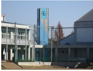
時計塔（時計設置）
